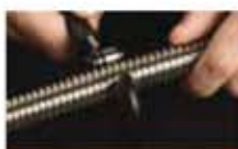
Utnij potrzebny odcinek rury
